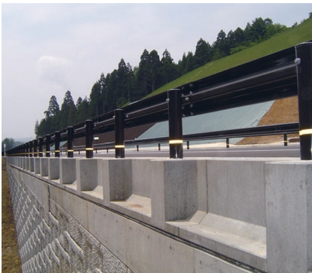
補強土壁直上設置の事例
