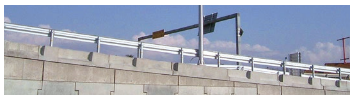
縦断勾配9%の施工実績例
