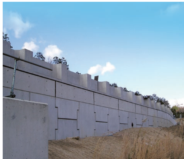
補強土壁直上設置の事例
