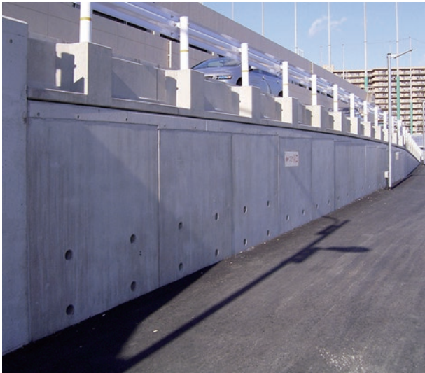
プレキャストL型擁壁直上設置の事例
