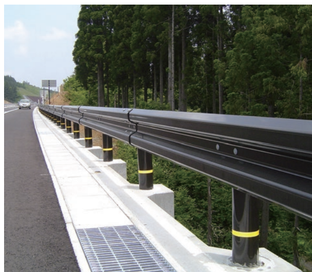
背面に側溝設置の事例
