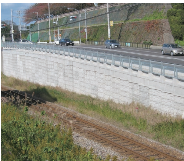
超軽量盛土直上設置の事例
