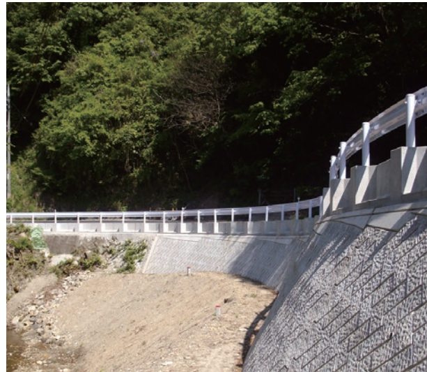
積ブロック直上設置の事例
