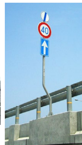
道路付帯構造物設置例 (標識・防護柵)
