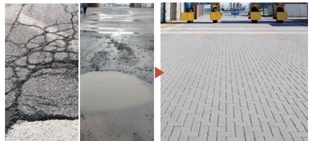
半たわみ性舗装
