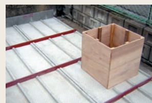
点検口設置状況
