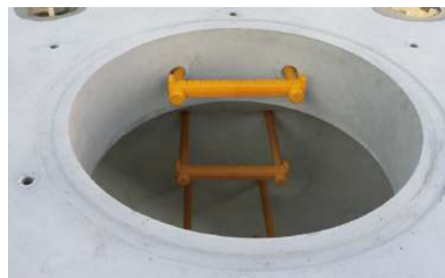
吸管投入孔取り付け位置
