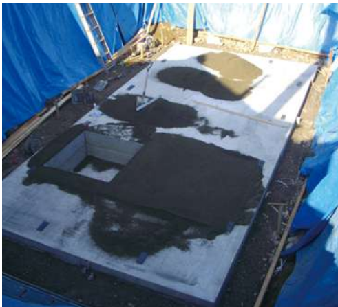
1 基礎コンクリート
