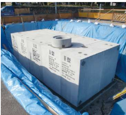
5 組立接合完了
